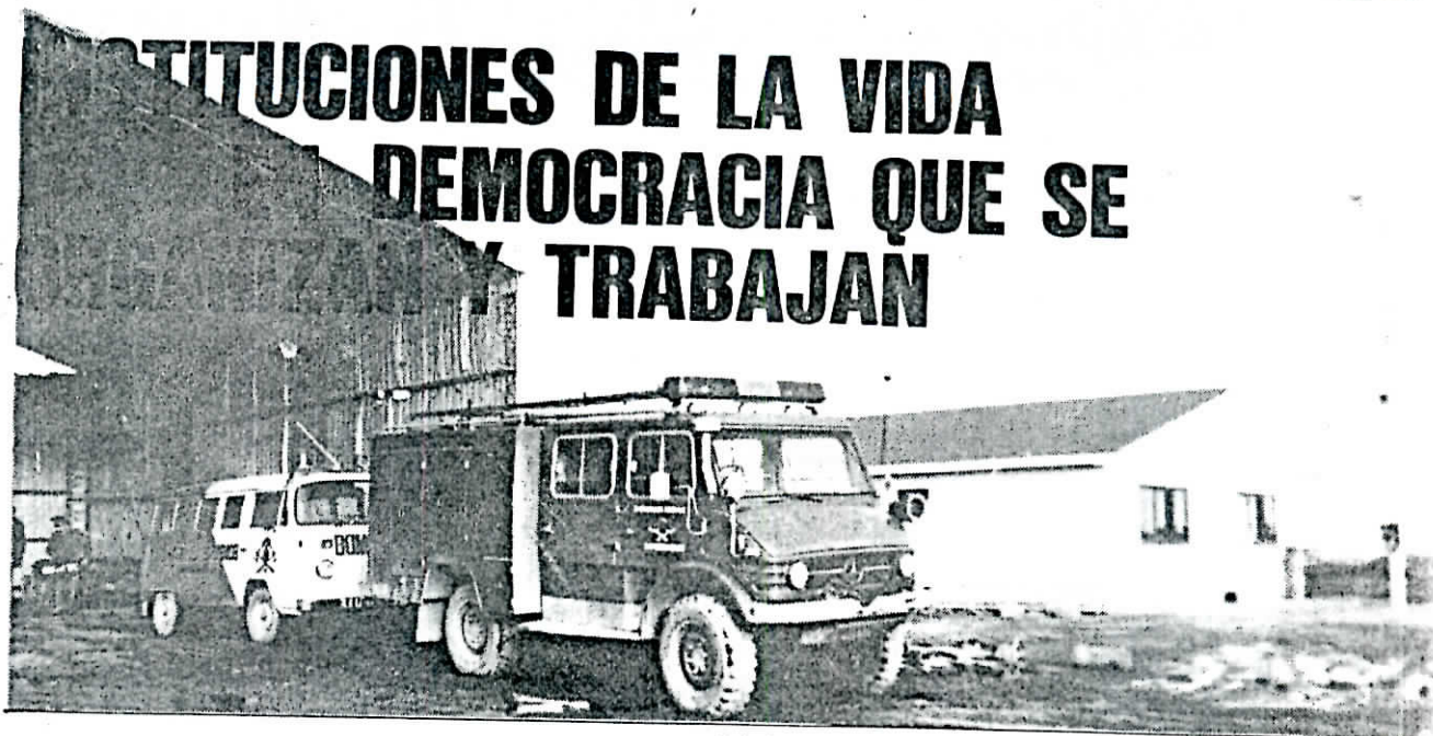
Galpón de unidades contra incendio del Cuerpo de Bomberos Voluntarios
